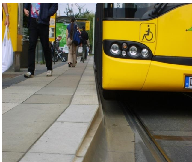
Rys. 8.5.2.1. Zalecane ukształtowanie krawędzi peronowej. Źródło: opracowanie własne.
