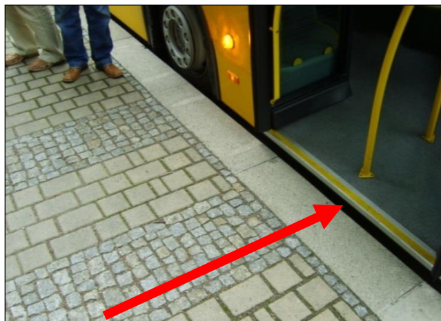
Rys. 8.5.2.2. Strefa wejściowa – inny rodzaj nawierzchni naprzeciwko pierwszych drzwi autobusu. Źródło: opracowanie własne.
