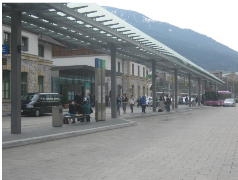
Rys. 12.2.2. Perony autobusowe przed dworcem kolejowym w miejscowości Landeck (Austria). Zaprojektowanie peronów w taki sposób ułatwia ich opuszczenie przez autobus.
